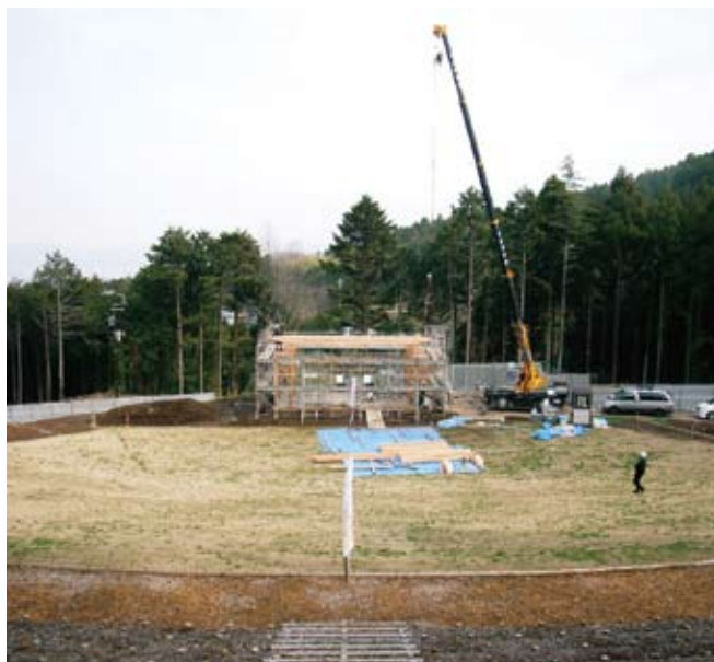
お野立所の建築工事着工
