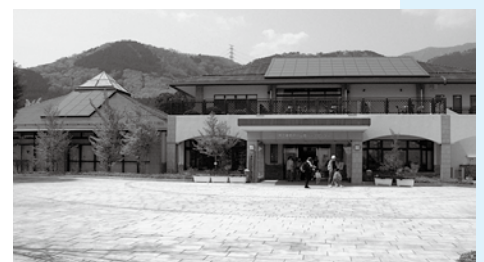
秦野戸川公園に設置した太陽光発電装置 （屋根の上2箇所）
