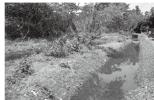
生態系に配慮した水路の整備（小田原市）
