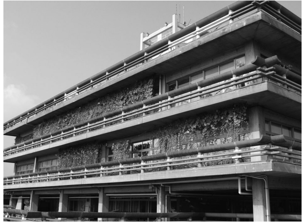
緑のカーテンに覆われた庁舎の様子
