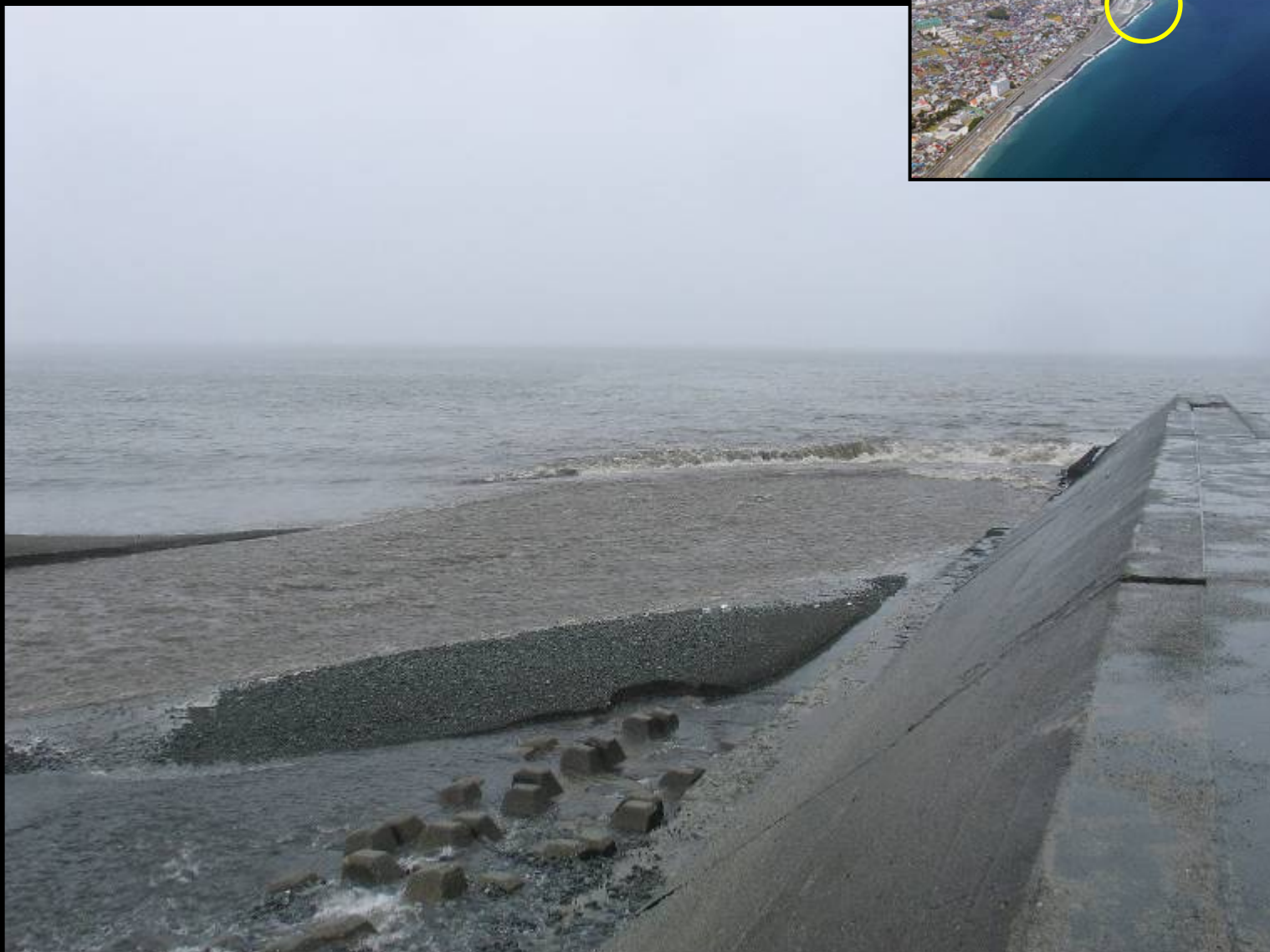
写真-20 射流状態で海に流れ込む洪水流
