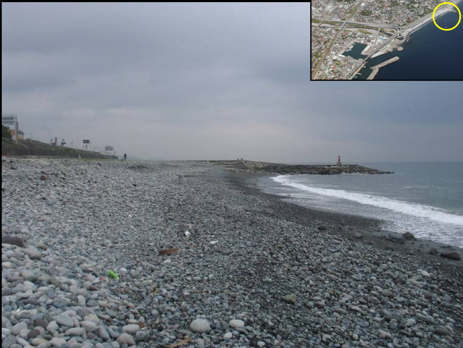
写真-2 御幸の浜の突堤の西側隣接部における礫の堆積
