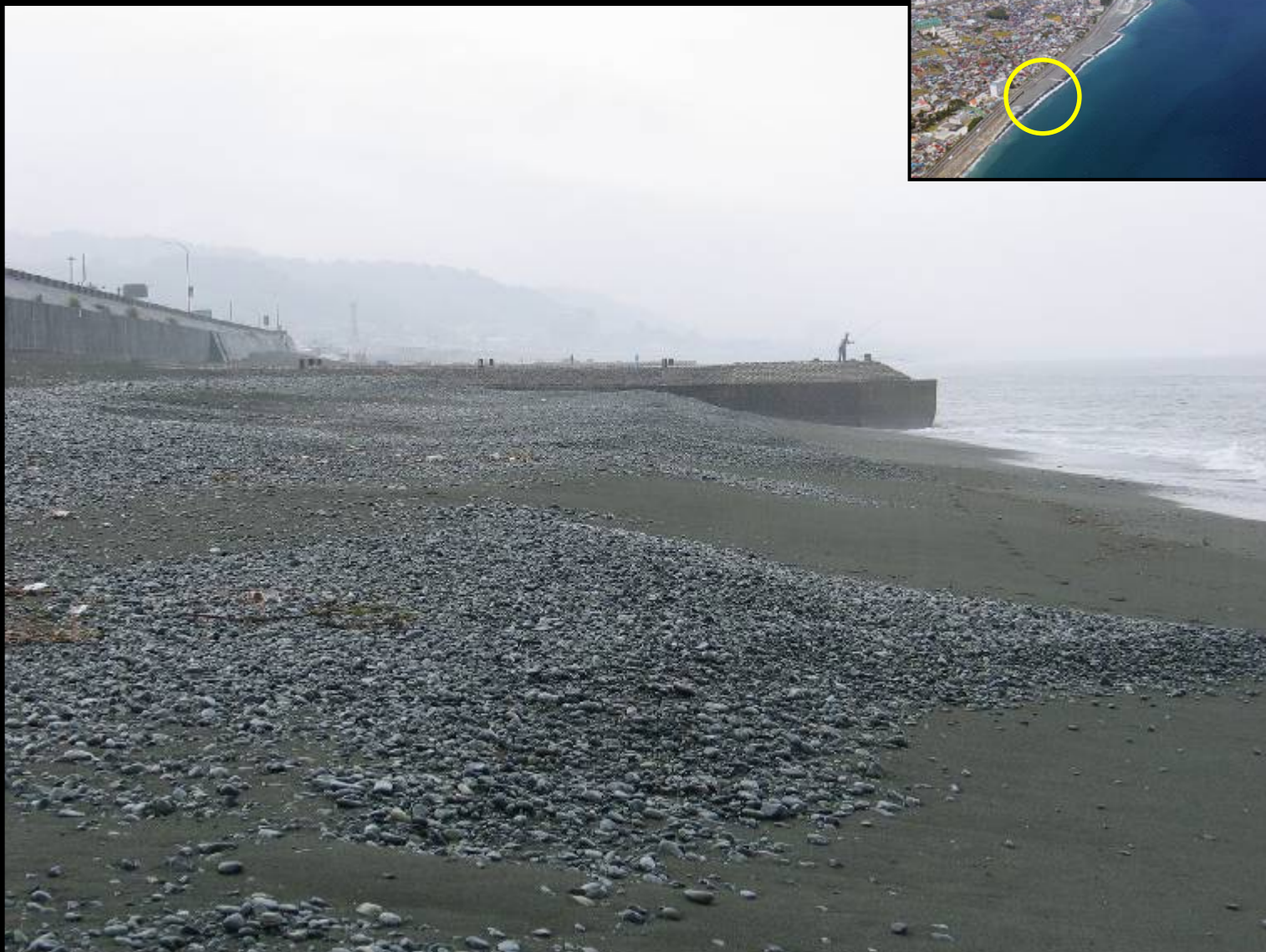
写真-16 西端の突堤上手側における砂礫の堆積
