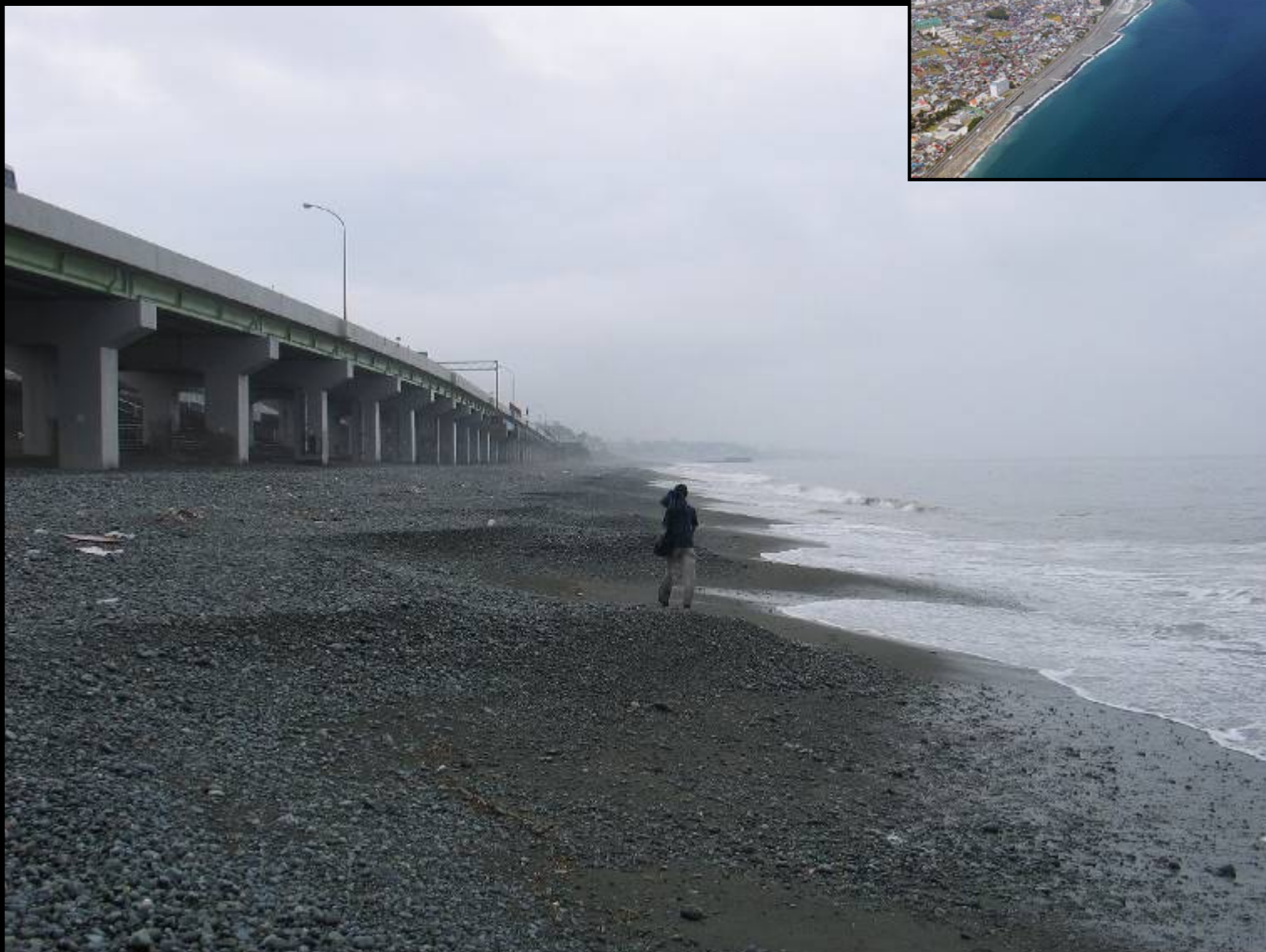
写真-23 遠方に二宮漁港の突堤を望む付近の海岸状況
