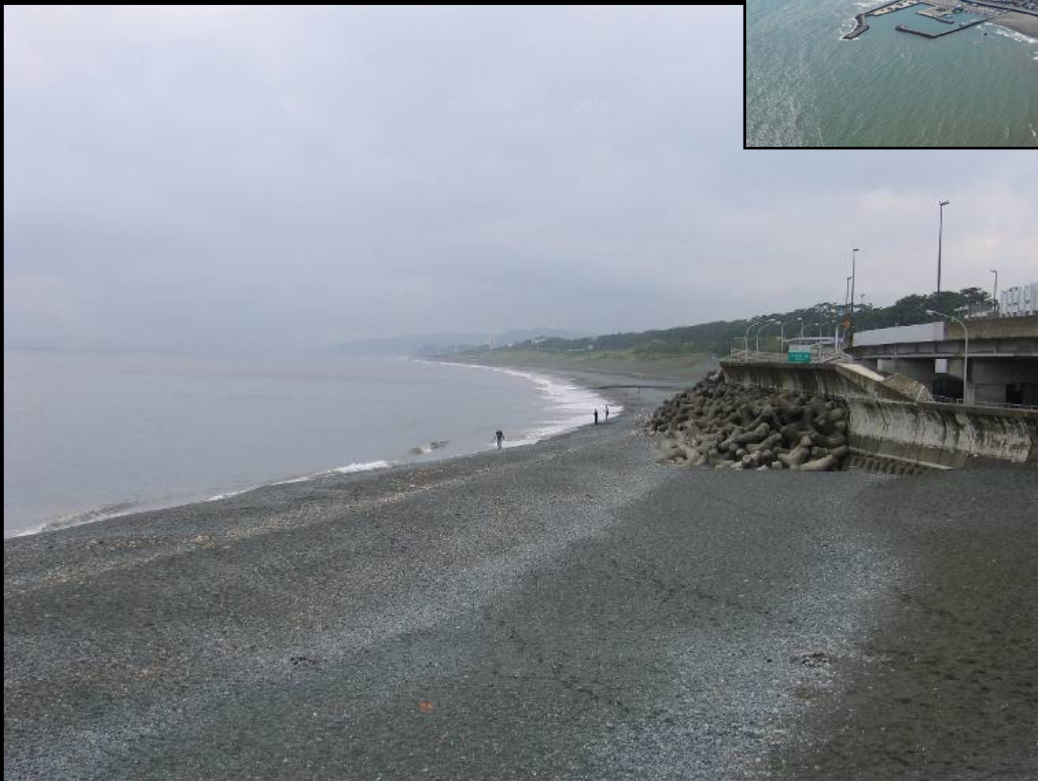
写真-30 大磯港の防波堤上から西湘海岸を西向きに撮影
