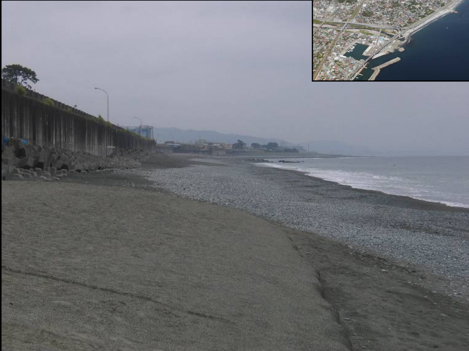
写真-7 盛土養浜により浜に置かれた砂
