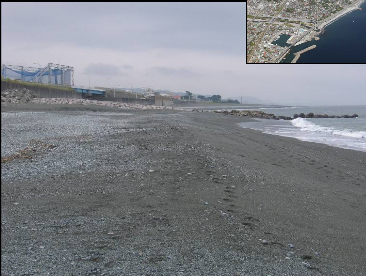
写真-9 山王川河口の西側直近にある突堤の上手側に形成されたバーム
