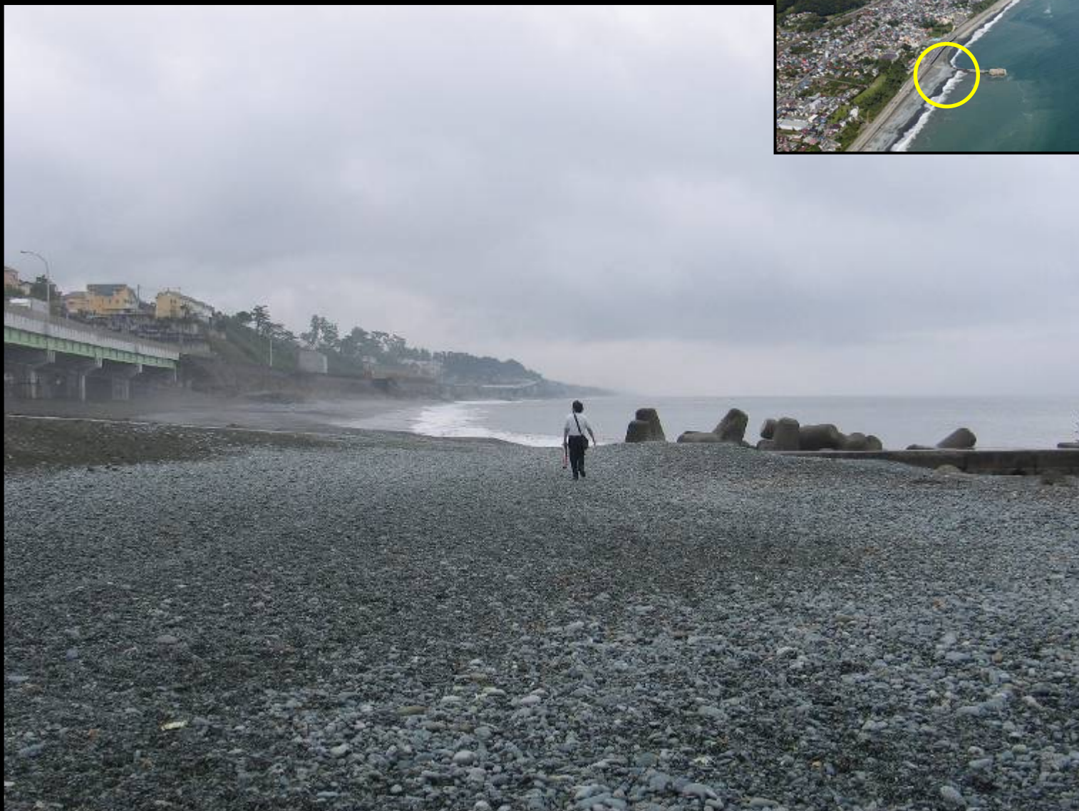
写真-25 二宮漁港の防波堤の天端まで堆積した礫
