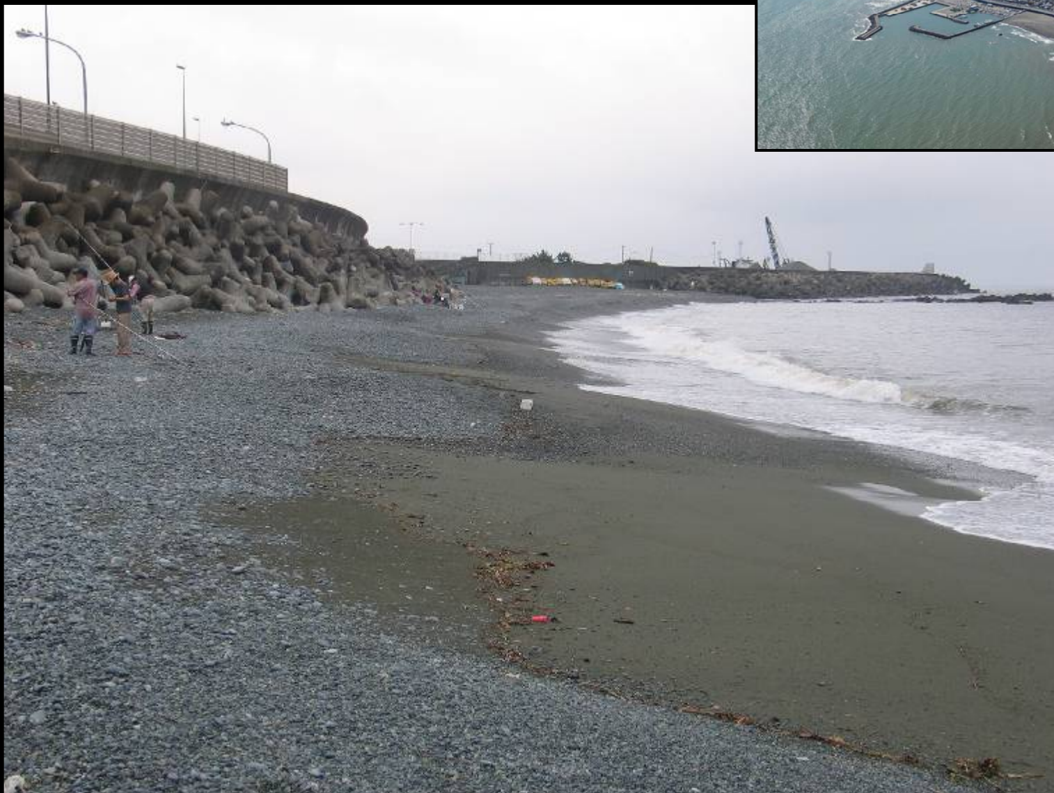
写真-28 大磯港防波堤とその西側隣接部の海浜を東向きに撮影
