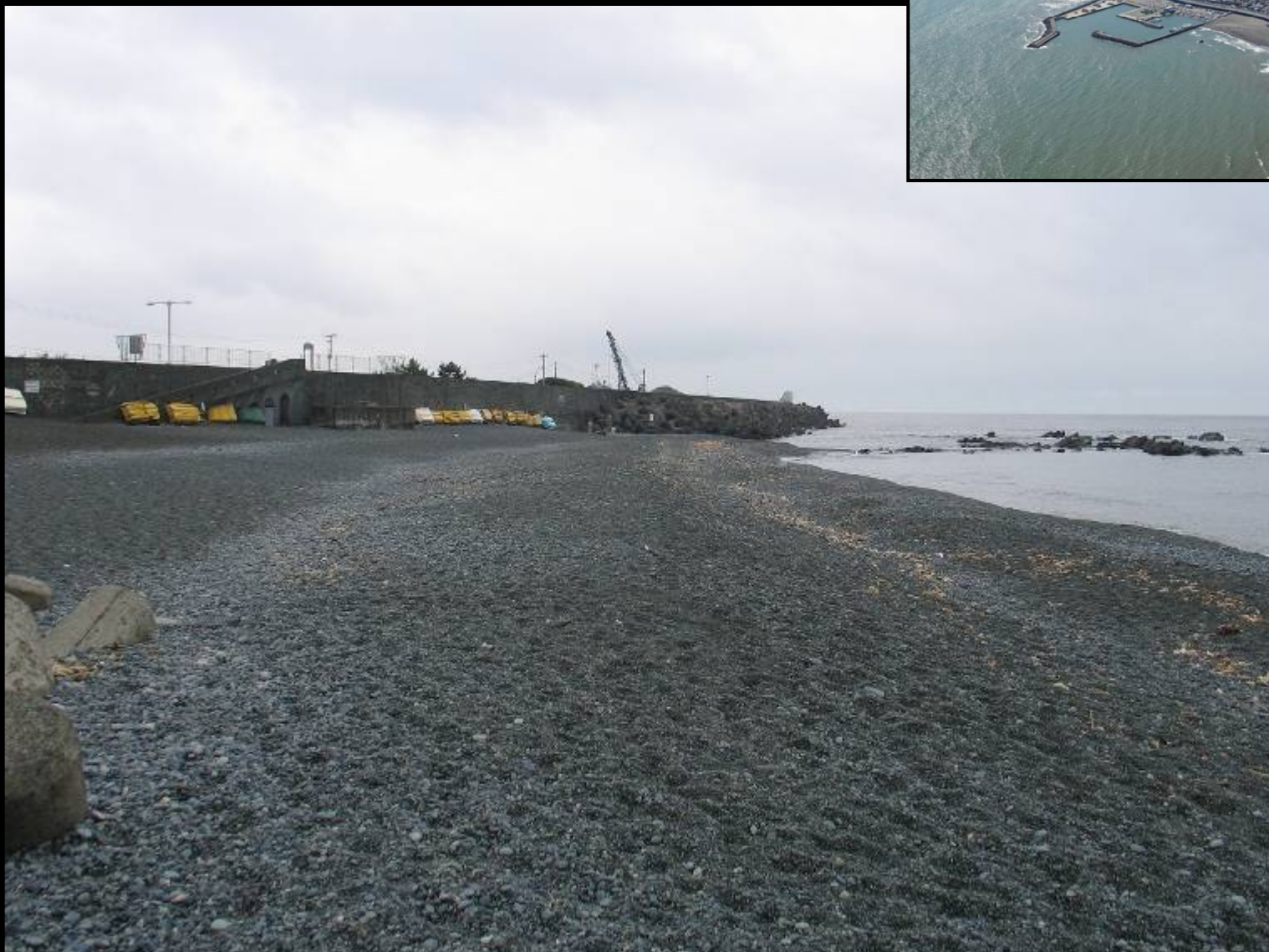
写真-29 大磯港防波堤に向かって伸びた礫堤
