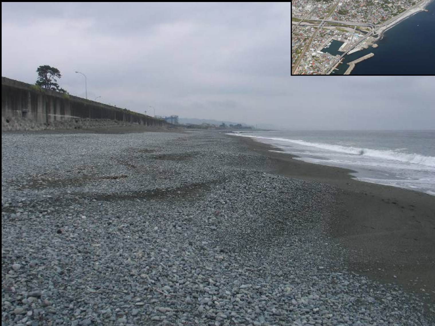
写真-8 盛土養浜区間前面の汀線付近に形成された礫を主要材料としたカスプ
