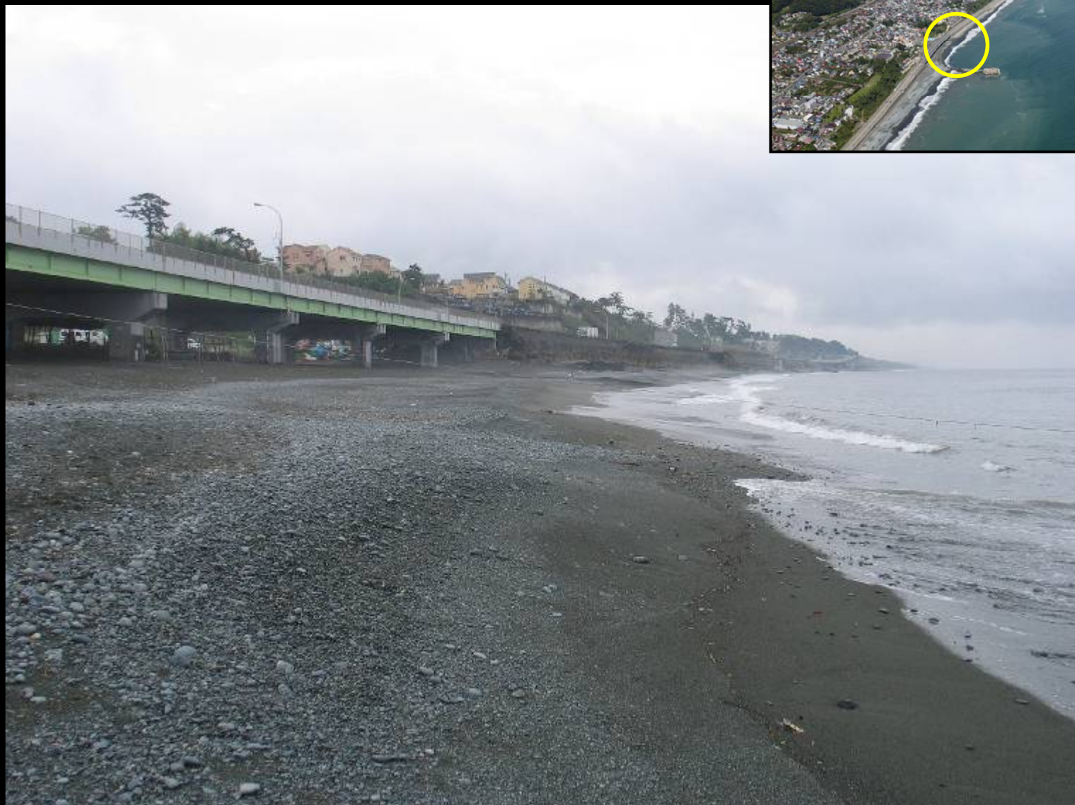
写真-26 二宮漁港の防波堤の東側隣接部の海岸状況
