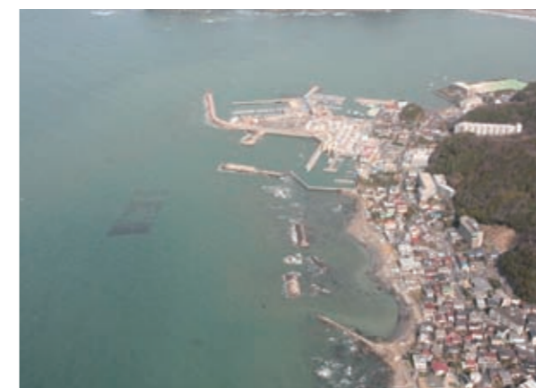
葉山海岸堀内地区 (H21.2)
