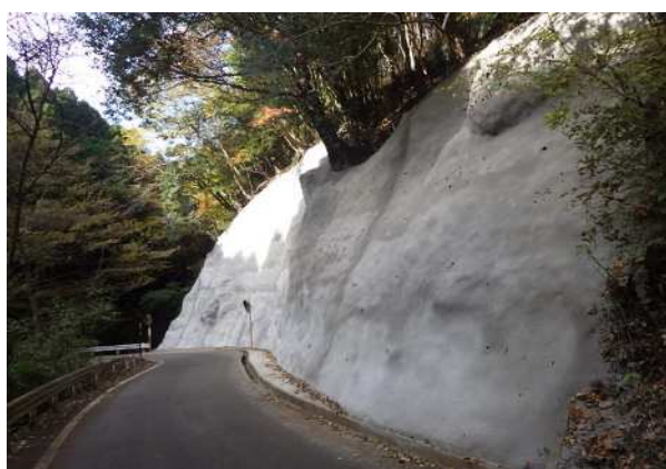
モルタル吹付工
