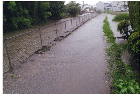
水路拡幅による周辺被害防止
