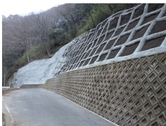
林道施設（法面保護工）
