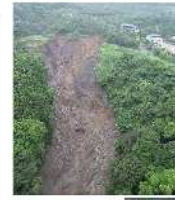
死者・行方不明者28名、住宅被害98棟 R3.7 静岡県熱海市
