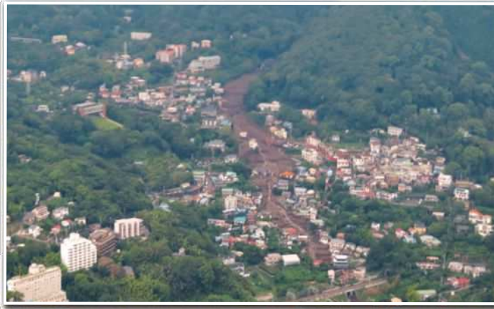
R3.7 静岡県熱海市 死者28名、住宅被害98棟
