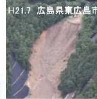
崩壊された土石の崩落
