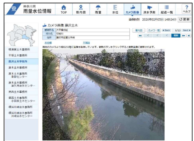
⑥ 河川監視カメラ画像表示
