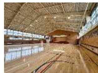
耐震化工事後の体育館
