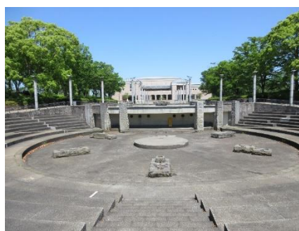
老朽化施設のリニューアル
