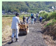
未舗装農道の舗装
