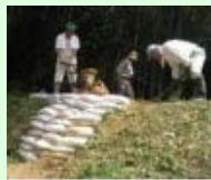
漏水箇所の補修
