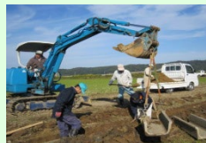
コンクリート水路の更新
