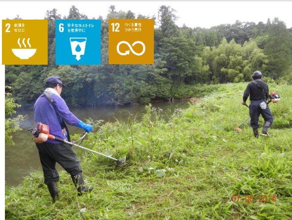
ため池堤体の草刈り
