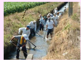
水路の泥上げ
