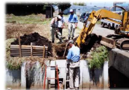
水路の補修(藤沢市)
