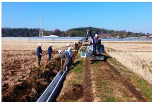
老朽化水路の更新
