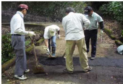
農道の維持補修
