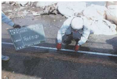
取水門の補修
