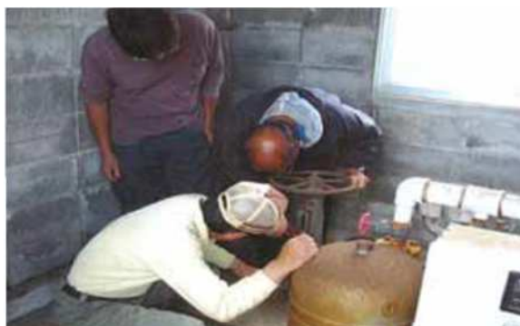
畑かん用ポンプの軽微な補修
