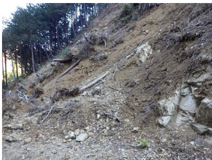
水源林の基盤の整備
