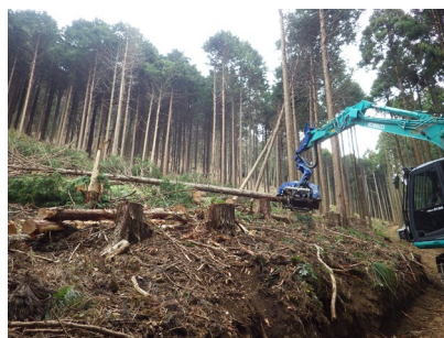
高性能林業機械を利用した 伐木作業の様子
