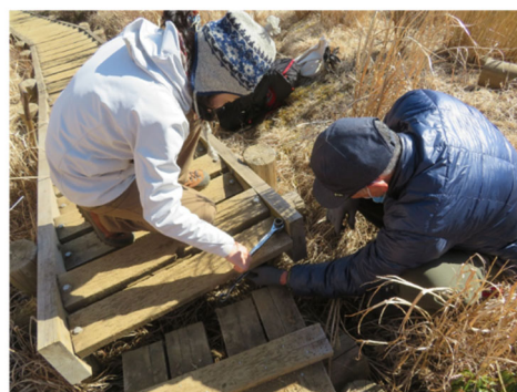
登山道を補修している様子
