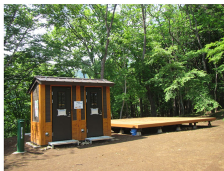
環境配慮型公衆トイレ (大倉高原山: 秦野市)
