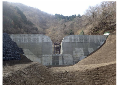
谷止工(峰ノ沢:山北町)
