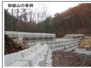
仮設砂防堰堤工
