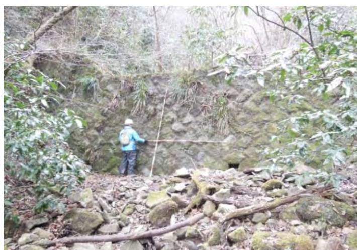
図 2-30 県内で最も古い砂防設備（常盤沢砂防堰堤 大正 13 年竣工）
