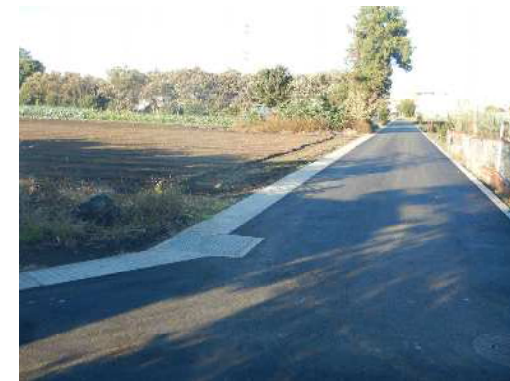
舗装完了区間の状況
