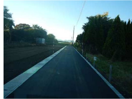
舗装完了区間の状況
