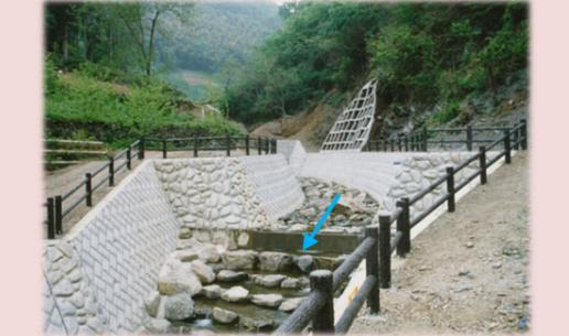
整備完了（護岸工・床固工）
