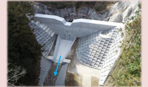
整備完了（不透過型砂防堰堤）
