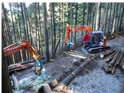
高性能林業機械を利用した 集材作業の様子
