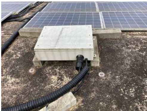
電力ケーブル切断及び電線管破損状況
