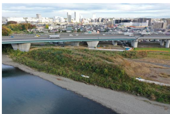
高水敷掘削工施工前
