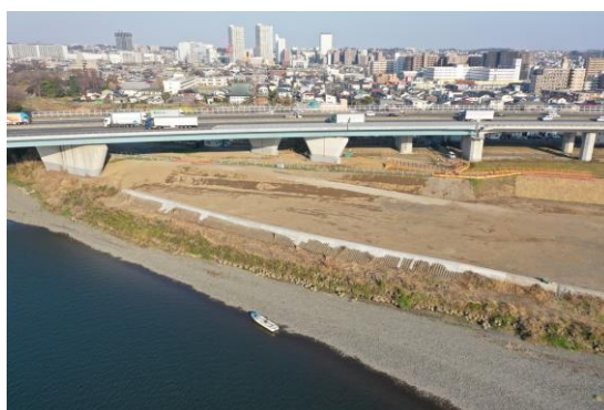
高水敷掘削工施工後
