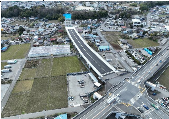
高架工区 (R6. 3撮影)
