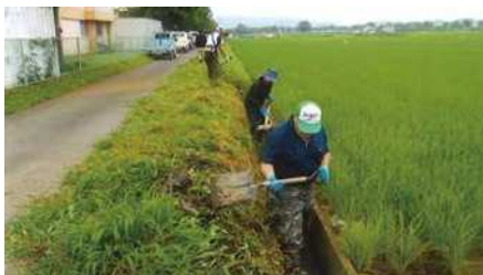
地域ぐるみで実施する水路の泥上げ作業(平塚市)
