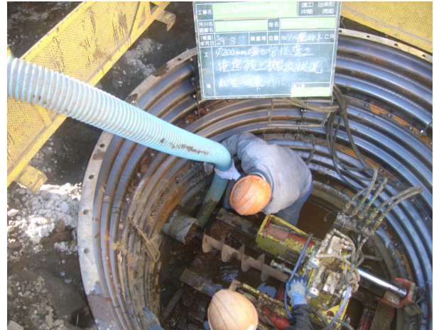
公共下水道の整備（相模原市）
