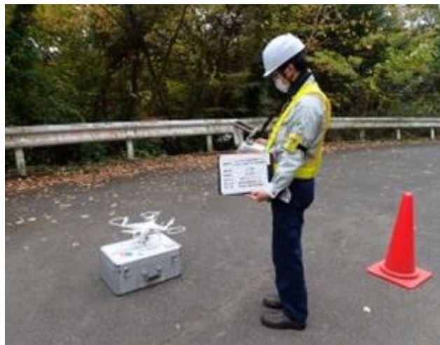
ドローンによる湖面撮影の作業風景
