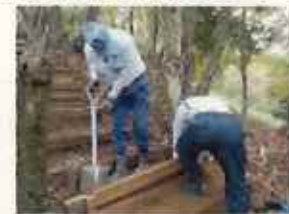
園内発生材を活用した小破修繕
