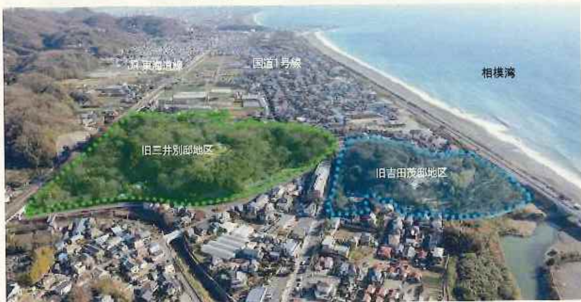
西の空から見た大磯城山公園全景
