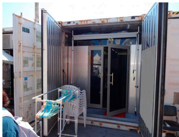
リオ2016大会のテストイベント時に設置された各国のコンテナ。日本とは異なり、居住施設として使用する場合でも、直置きされている
