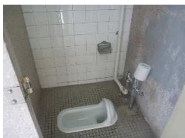
【トイレ改修イメージ】 <改修前>
