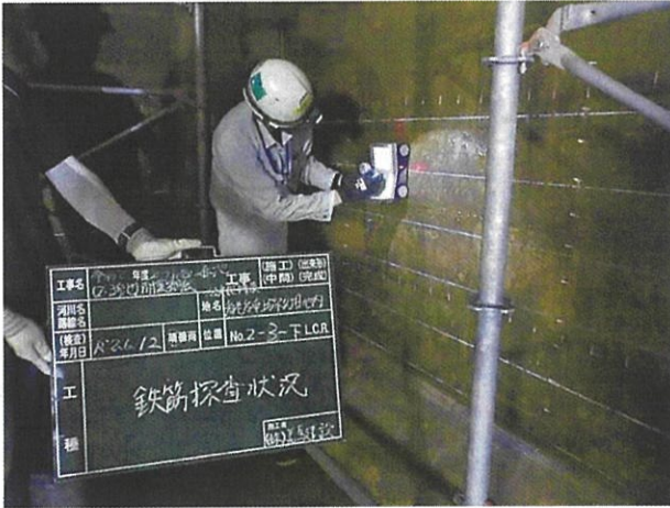
配水池内部の柱の鉄筋を探查している様子
