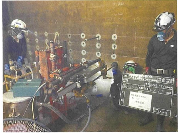
配水池内部の柱に鉄筋を挿入して、補強している様子
