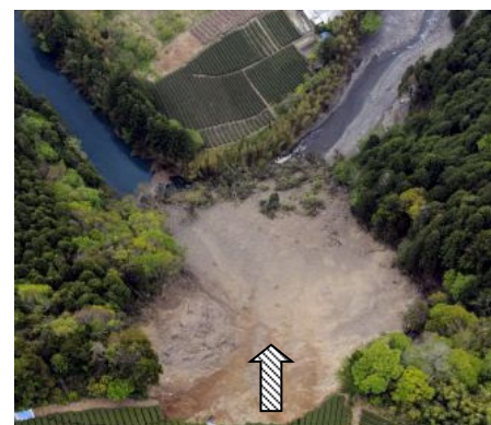
2013年4月 浜松市で発生した斜面崩壊により閉塞する一級河川 杉川
