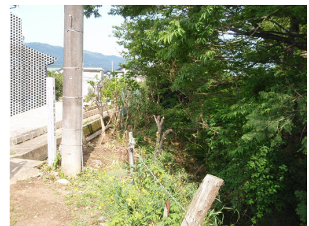
写真③ がけ地と家屋の近接状況
