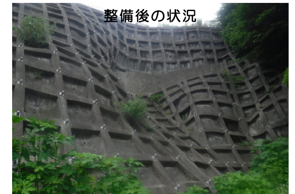
写真④ 急傾斜地崩壊防止施設(法枠工)の整備例
