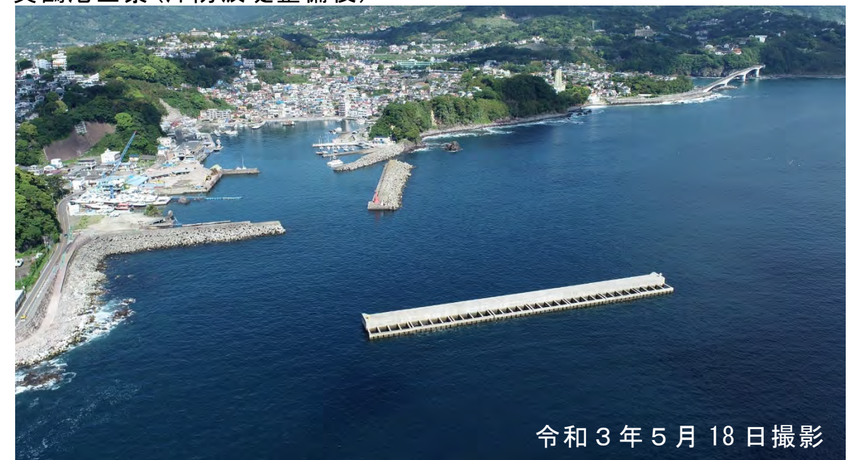
真鶴港全景(沖防波堤整備後)
