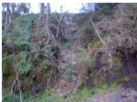
写真② 斜面の崩落跡
