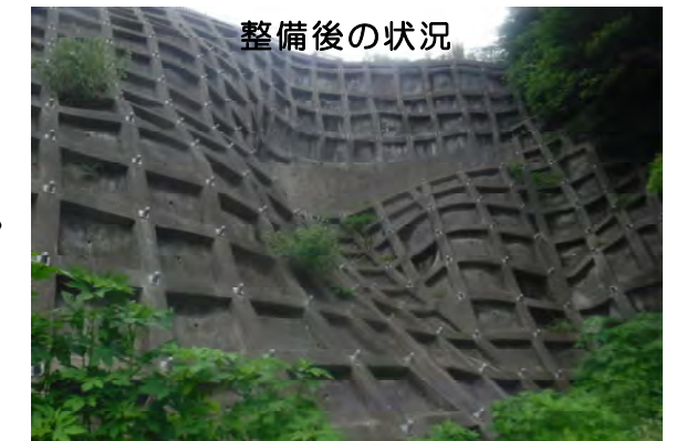
写真④ 急傾斜地崩壊防止施設(法枠工)の整備例
