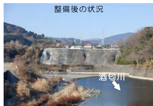
写真① 急傾斜地崩壊防止施設（法枠工）の整備例
