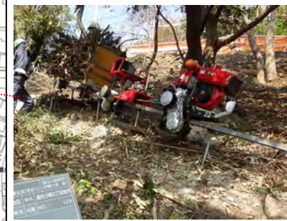
裏斜面から資材を運搬
