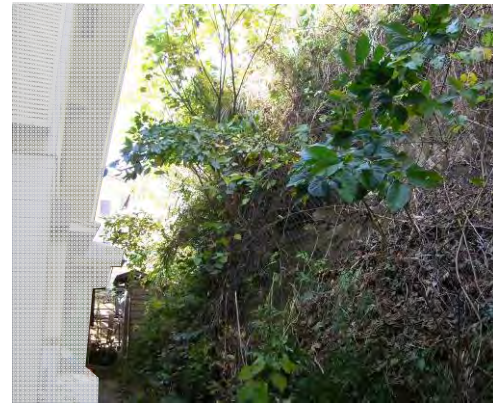
写真②がけ地と家屋の近接状況
