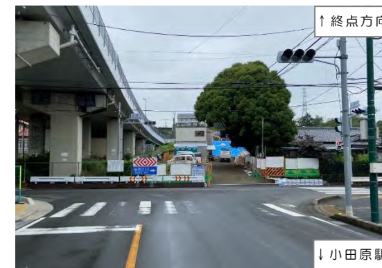
(都) 城山多古線 起点部
