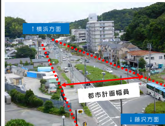
未整備箇所の現道状況
