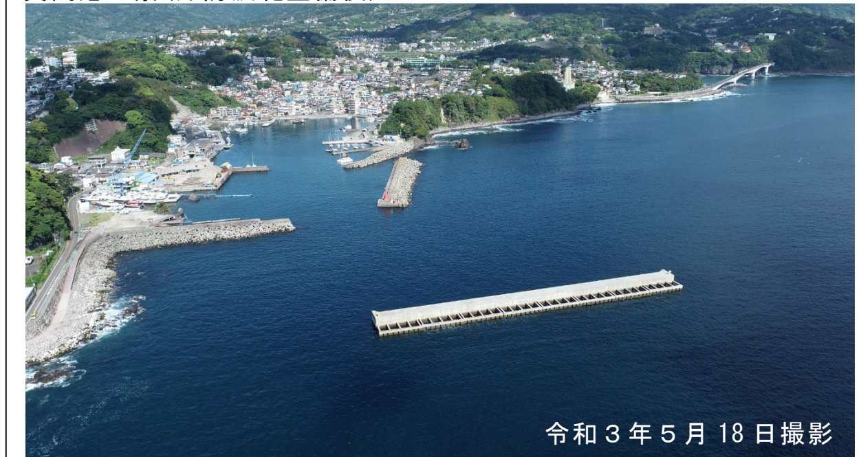
真鶴港全景(沖防波堤整備後)
