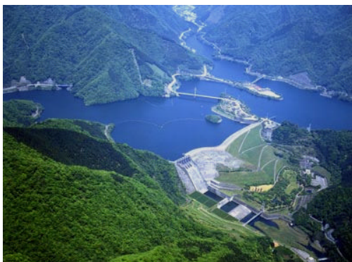
写真3 三保ダムと丹沢湖 (昭和54年完成)
