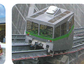
宮ヶ瀬ダムインクライン
