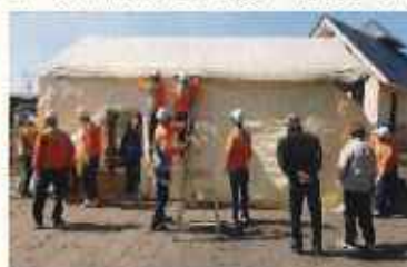
防災パーゴラの設営
