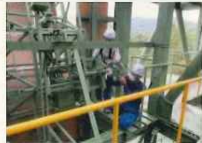
リードウォールの保守点検
