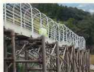
ローラー滑り台の点検 (おだわら諏訪の原公園)
