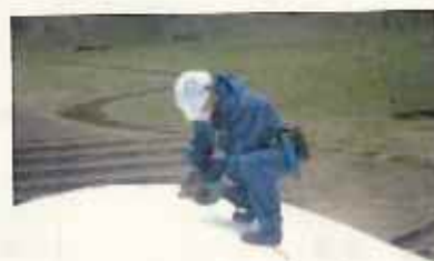
トランポリンの補修作業
