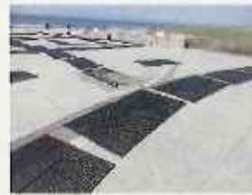
ゴムマットの敷設
