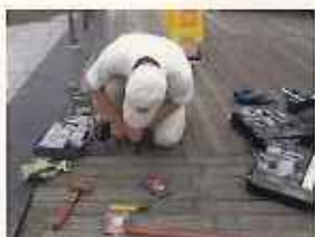
デッキ修繕の様子
