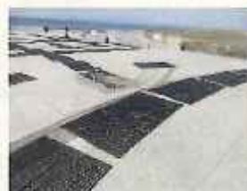
ゴムマットの敷設
