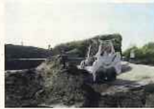
自社重機による 堆砂除去
