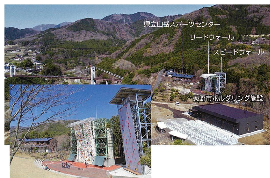
「県立山岳スポーツセンター」と「はだの丹沢クライミングパーク」 (リードウォール・スピードウォール) (ボルダリング施設)
