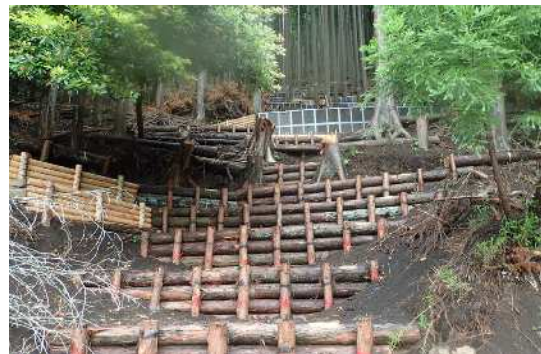
復旧対応後の様子 (土壌侵食防止工)
