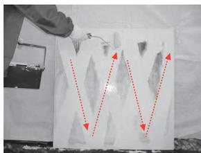
②軽く上から下へ、下から上に、そして横へとローラーを動かして塗料を伸ばして仕上げます。
